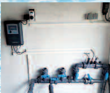
Misst und reguliert den PH-Wert und den Chlorgehalt für optimale Wasserqualität: Moderne Dosiertechnik.
