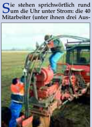
Auf Ackerflächen werden Mittelspannungskabel eingepflügt
