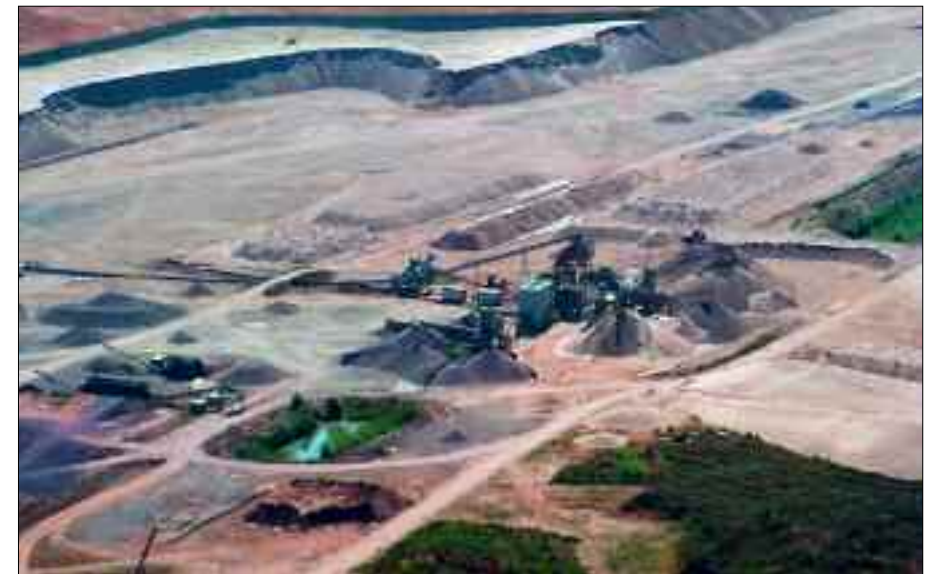
Luftbild der Kiesgrube Groß Ziethen
