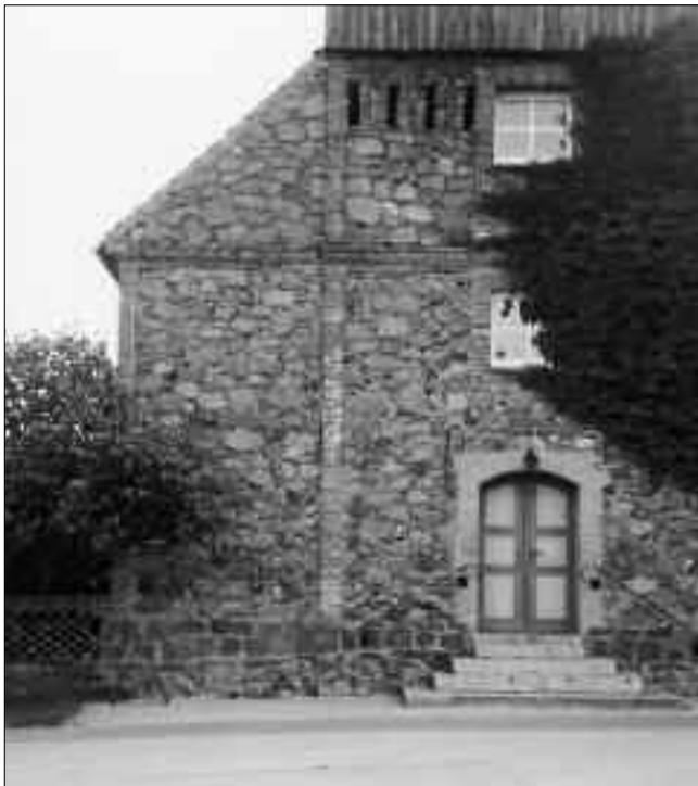
Ein Bauwerk aus Feldsteinen, die aus den Steingruben Althüttendorfs stammen.
