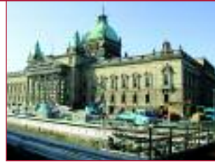
Das Reichsgericht in Leipzig – hier übernahm die Firma Freitag die Umlegungsarbeiten der Stromversorgung während der Bauarbeiten zur Freilegung des Pleiße-Mühlgrabens.
