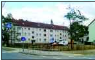
In diesem Jahr werden die Außenanlagen Ecke Landhausstraße/Paul-Singer-Straße erneuert.
