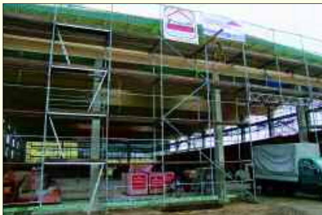
Der Neubau der Sporthalle ist fast abgeschlossen.
