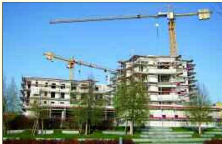
Baumaßnahmen am Haus Polderblick
