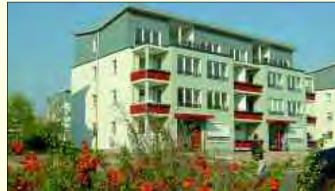
Im Dr.-Wilhelm-Külz-Viertel sind die Ergebnisse des Stadtumbaus sichtbar, aus Plattenbauten wurden diese modernen Häuser
