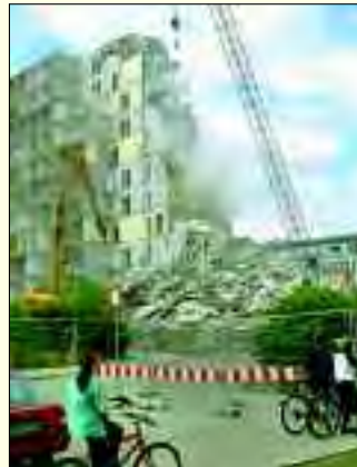
Abbruch von elfgeschossigen Plattenbauten im Stadtumbau
