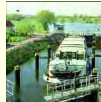
Schleuse an der Hohensaaten-Friedrichsthaler Wasserstraße
