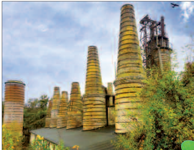
Technik-Denkmale im Museumspark – Schachtofenbatterie.
