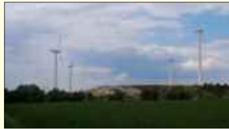
Der Energiepark Rüdersdorf – installierte Leistung 5,4 Megawatt, windabhängig
