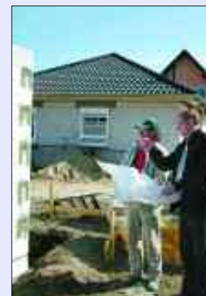
Die CoMa GmbH realisiert jeden Bauherrenwunsch
