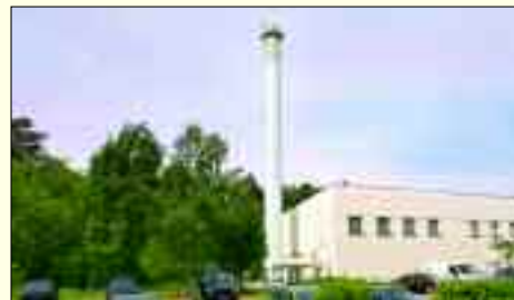
Tochterunternehmen der WBG: Sicher mit Wärme versorgt dank modernster Technik
