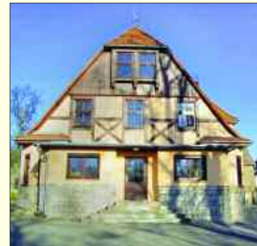
Ein Haus für ambulantes Wohnen in der Karl-Liebknecht-Straße 28a in Alt-Rüdersdorf
