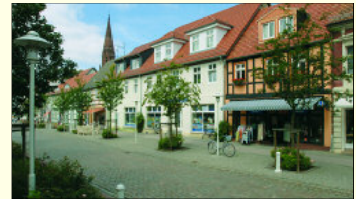
Historische Gebäude prägen das Bild der liebevoll sanierten Innenstadt Pritzwalks
