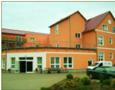
Hauptgebäude der Senioren-Residenz-Prignitz
