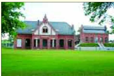
Das Wasserwerk – Schmuckstück der Stadtwerke
