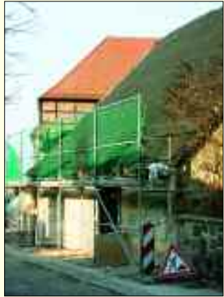
Sanierung des Waschhauses
