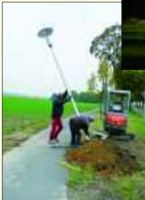
Elektroanlagen Zepernick GmbH bei der Installation der neuen Straßenbeleuchtung.
