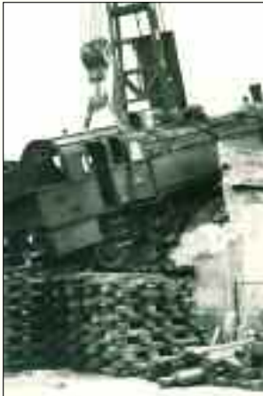
Bergung der verunglückten Rangierlok mit einem Spezialkran der Reichsbahn.
