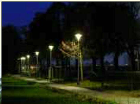
Modern und effizient, die neue Straßenbeleuchtung zwischen Schwanebeck und Zepernick – realisiert mit E.ON edis.
