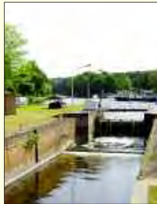
Die Schleuse in Malz
