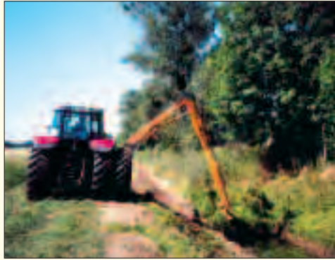
Grabenräumung in der Nähe von Elstal
