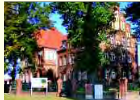
Alte Schule: Gemeindezentrum und Feuerwache
