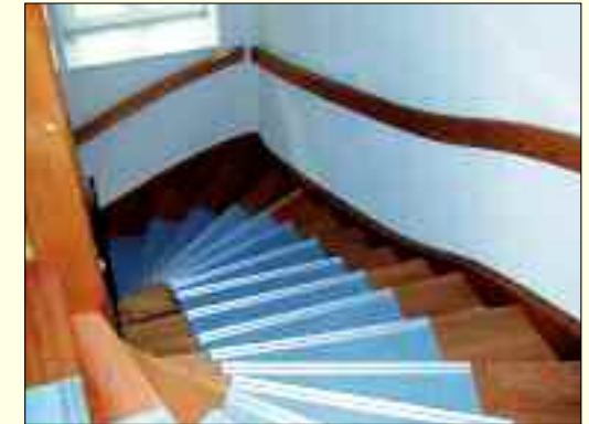
Der Innenausbau kann sich sehen lassen.
