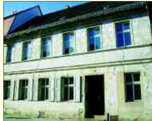
Aus alt mach neu: Ansicht des Hauses in der Lange Straße 12 vor der Sanierung.
