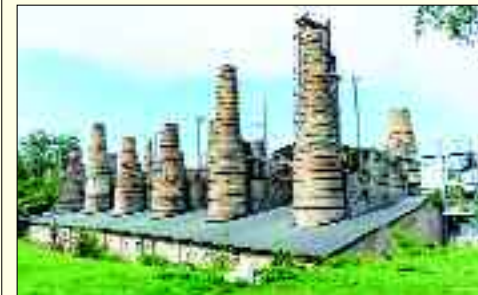
Die Schachtofenbatterie mit 18 Öfen.
