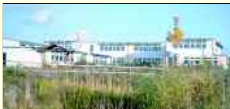
Das Freie Gymnasium Zepernick – unbeschwertes Lernen in modernen Gebäuden
