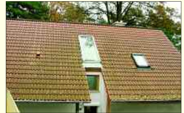
Foto oben: ein mit Algen und Moosen befallehenes Dach vom November 2003 Foto unten: dasselbe Dach 2,5 Jahre später – die reinigende Wirkung des Aktiv-Firstes ist deutlich erkennbar
