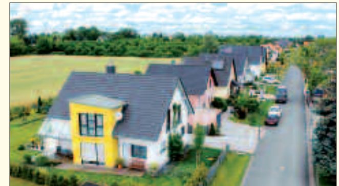
Die neu entwickelte Siedlung Wiesenblumenweg in Leipzig-Holzhausen wird im Jahr 2022 fertig errichtet sein.
