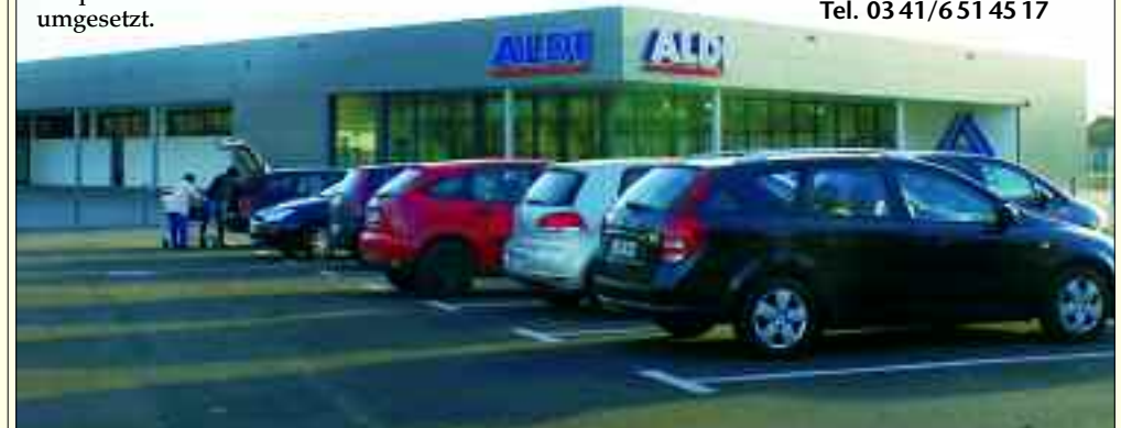
Dem neuen Aldi-Markt werden in der Hugo-Aurich-Straße weitere bürgernahe Einrichtungen folgen, so dass das Areal bald mit Recht den Titel „Engelsdorfer Stadtteilzentrum“ tragen wird.
