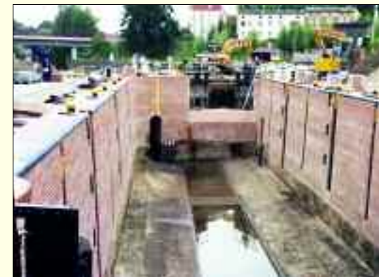
Die original rekonstruierte Schleuse in Eberswalde
