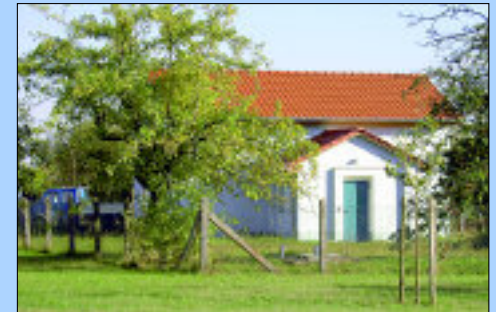
Das Wasserwerk in Groß Ziescht
