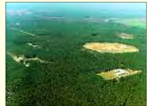
Das Freiversuchsgelände der BAM mit Sprengplatz (400 m Durchmesser) und Tagungszentrum – links im Bild die Steigungsbahnen der Verkehrsversuchsanlage (FKVV)
