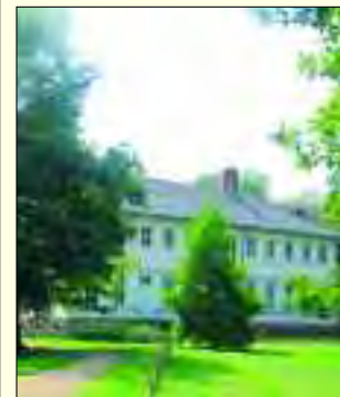
Der bereits sanierte Teil des Baruther Schlosses
