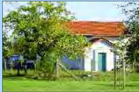
Das Wasserwerk in Groß Ziescht
