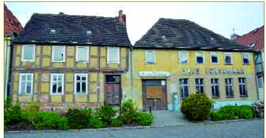
Dem Haus Uckermark am Marktplatz steht seine Sanierung verbunden mit An- und Umbau endlich unmittelbar bevor.
