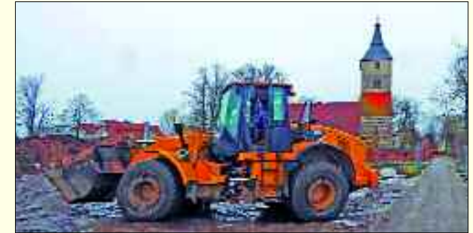
Ohne Pause, Tiefbauarbeiten an der künftigen Schlossterrasse
