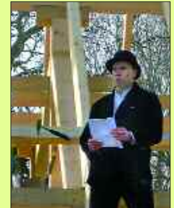
Ein zünftiger Richtspruch vom Zimmermann Feinkorn der Holzbau Hunold GmbH & Co. KG.
