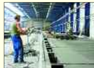
Hier entstehen die begehrten Wandbauteile aus Blähton und Beton.
