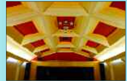
Die sanierte Saaldecke des geschichtsträchtigen Gebäudes
