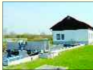
Rechenhaus und Sandfang
