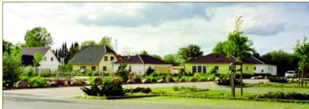
Neues Gesicht Torgelows: Straßen und Wohngebiete wurden saniert und neu erschlossen
