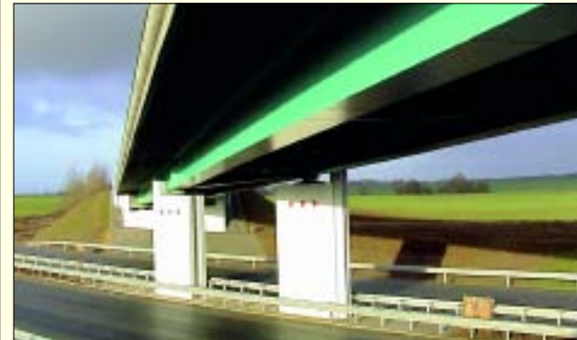
Die neuen Autobahnbrücken, wie sie immer häufiger in Deutschland zu finden sind, werden von Stahlträgern der SMA gestützt
