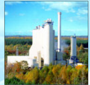
Das Kraftwerk der GMB liefert seit 1999 Strom und Wärme für Senftenberg
