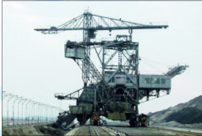
Sanierungsarbeiten mit schwerer Technik für die LMBV
