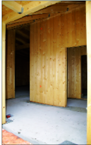
Der Anbau des Ortsteilzentrums Dölzig soll Ende des Jahres 2015 fertig gestellt sein.
