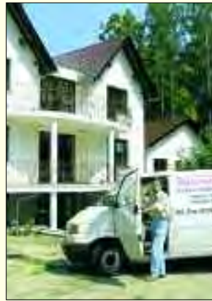
Detlev Nedemanskis Referenz – die Fassade seines Wohnhauses
