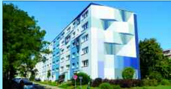
20 Wohneinheiten wurden in der Friedrich-Engels-Straße saniert.
