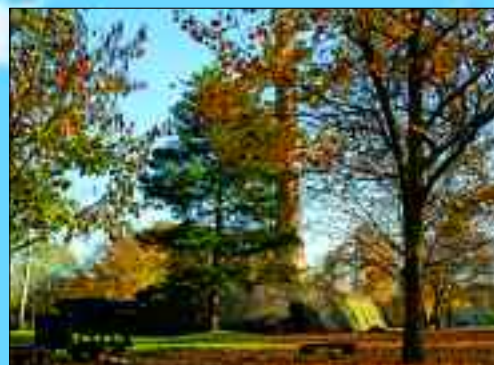
Der alte, begehbare Ziegeleiofen ist das high-light im Rüdersdorfer Ortsteil Lichtenow.
