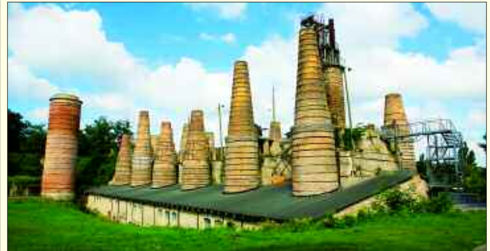
Bedeutendes Industriedenkmal: Die historische Schachtofenbatterie im Museumspark in Rüdersdorf.
