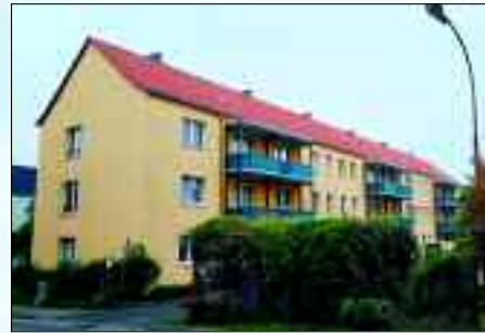
Die Mieter am Kalkberger Platz freuen sich über die neuen Balkone.
