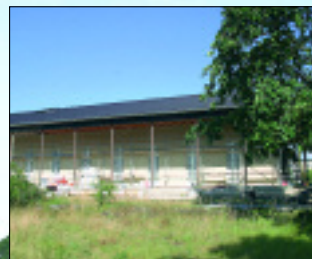
Das damals errichtete Aero-Clubhaus wird derzeit renoviert und restauriert
