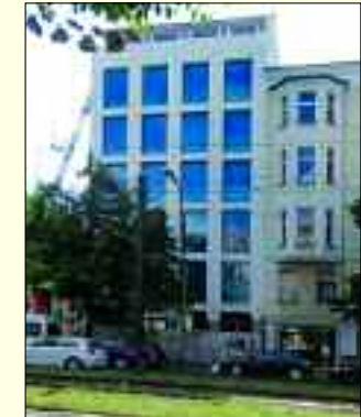
Dämmarbeiten in der Berliner Torstraße
