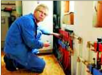
Hansjoachim Hohlfeld ist auf energiesparende, ökologische Anlagen spezialisiert
