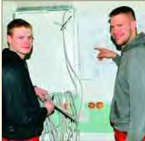
Geselle Steffen Wolf und Azubi David Merkel (rechts) beim Einbau eines Verteilerkastens.
