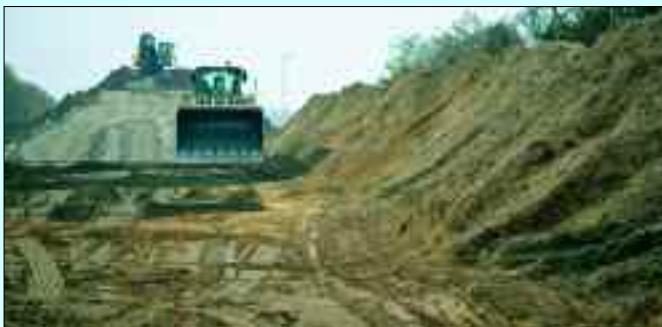
Die Arbeiten am Dreieck Schwanebeck sind in vollem Gange
