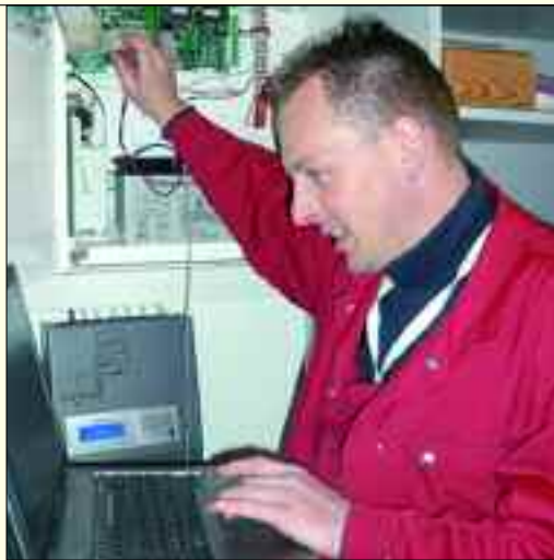
Der Meister Lars Höhne bei der Inbetriebnahme einer Hausalarmanlage
