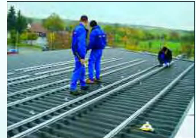
November 2008 kurz nach Baubeginn
