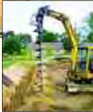
Einbringung von Spiralkollektoren
