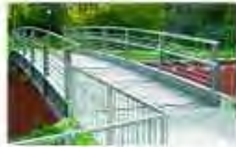
Fuß- und Radwegbrücke über die Parke
