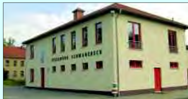
Das Gebäude der Freiwilligen Feuerwehr in Schwanebeck
