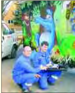
Dietmar Krause und Azubi Michael Göbel erstellen mit Hilfe modernster Technik ein Inspektionsprotokoll der Trafostation Gehrenberge in Schwanebeck
