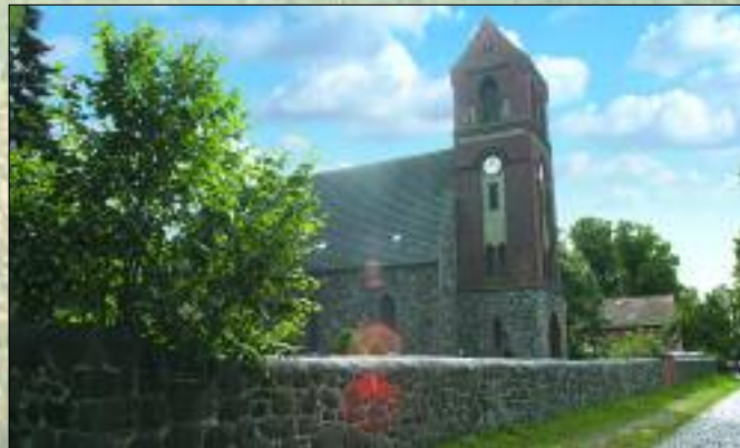
Die Schwanebecker Kirche steht im Ortszentrum direkt an der Bundesstraße 2, die Berlin und Stettin verbindet
