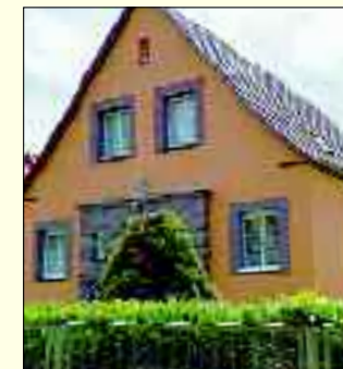
Nachher: Top saniert!
