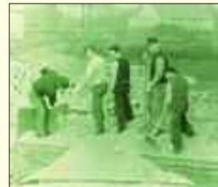
Spatenstich der ersten Blöcke in der Anderslebener Straße
