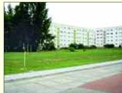
Neue Ausblicke im Wohngebiet „Wasserrenne“ nach erfolgtem Abriss
