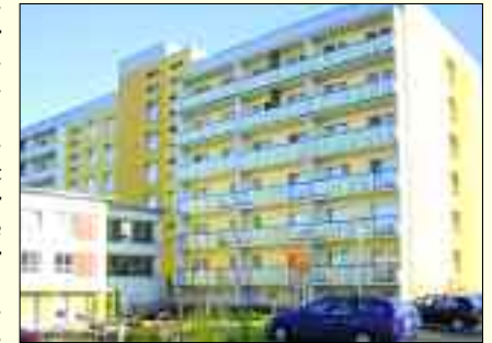
Die Seniorenwohnungen im DRK-Betreuungszentrum werden seit diesem Jahr durch die Genossenschaft verwaltet
