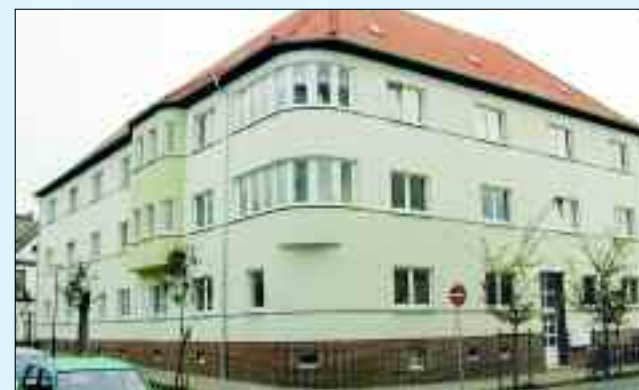
Das Objekt Rosa-Luxemburg-Straße 9/Petersilienstraße 5 ist komplett saniert
