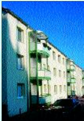
Dieser Block in der Magdeburger Straße wurde nicht nur saniert, sondern erhielt auch noch neue Balkone.
