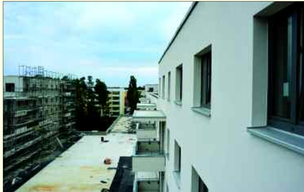
Wohnungen für Ludwigsfelde: Die Baustelle der „Märkischen Heimat“ in der Clara-Zetkin-Straße 26-36.
