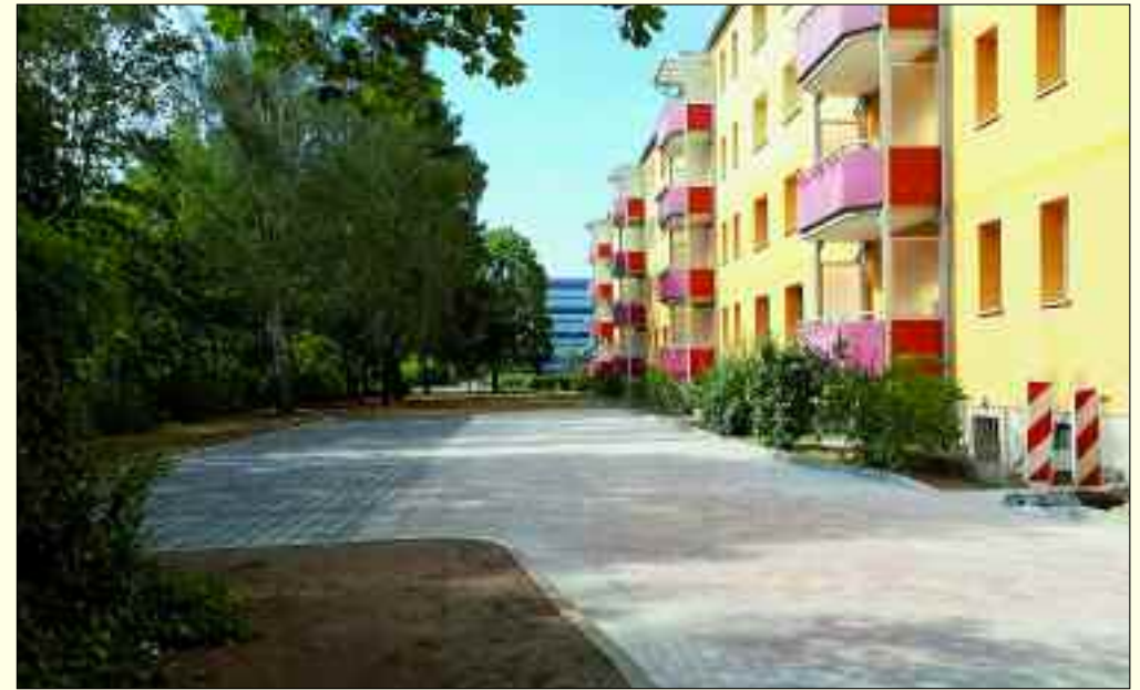
Die neuen Stellplätze im Stadtgebiet West verbessern die Parksituation der Mieter erheblich.
