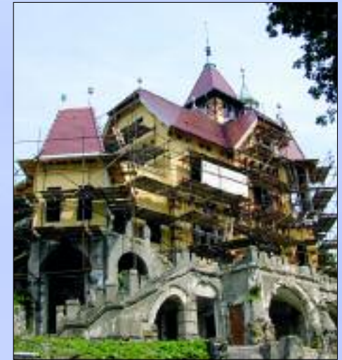
Arbeiten an der Außenfassade der Burgsbergwarte, Stand Juni 2005
