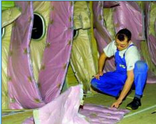
Aus Seifhennersdorf/Oberlausitz kommt die Isoliermatteninstallation in Flugzeugen, hier im Mitteldeck eines A 380
