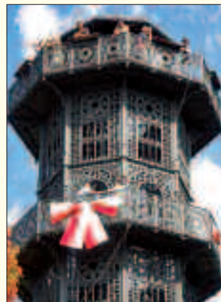
Der weltweit einzige gusseiserne Turm steht in Löbau.
