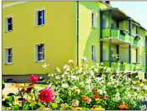
Die nachgerüsteten Balkone kommen bei den Mietern besonders gut an.
