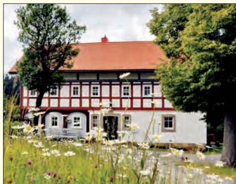
Umgebindehaus in Jonsdorf
