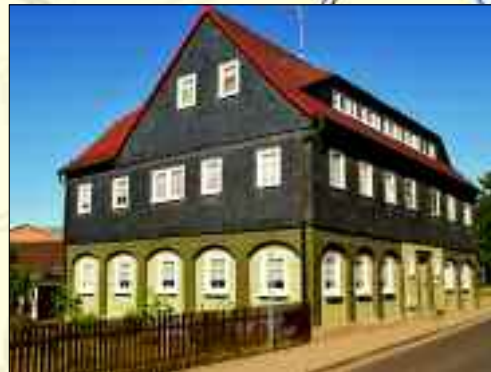
In der Rumburger Straße befinden sich einige schön restaurierte Umgebinderhäuser.
