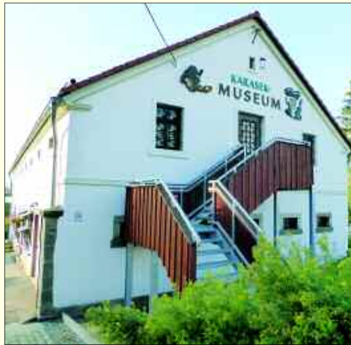
Nach umfangreicher Sanierung in neuem Glanz – das „Räubernest“.
