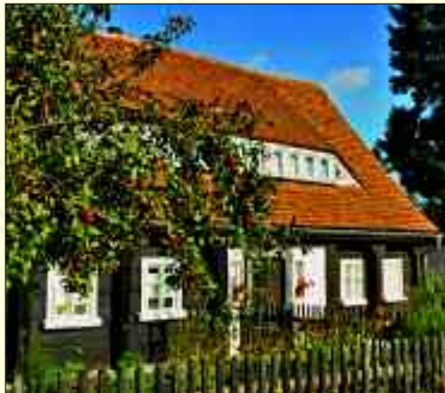
Typisches Umgebinderhaus mit Apfelbaum in der August-Hoffmann-Straße.
